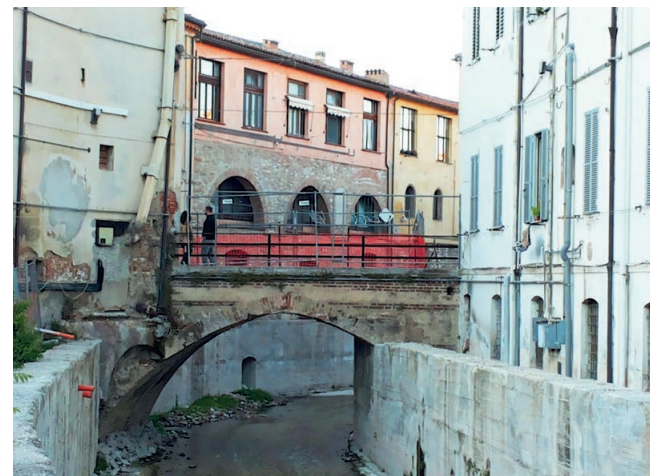
Il Ponte di San Rocco, nella zona in cui i lavori sul fiume Giano si sono fermati qualche anno fa
